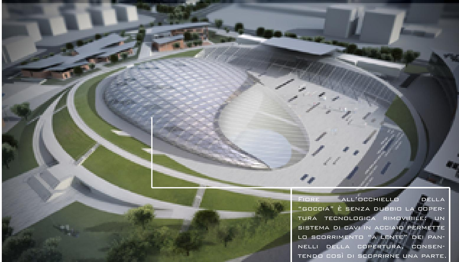
FIDRE ALL'OCCHIELLO DELLA "GOCCIA" È SENZA DUBBIO LA COPERTURA TECNOLOGICA RIMOVIBILE: UN SISTEMA DI CAVI IN ACCIAIO PERMETTE LO SCORRIMENTO "A LENTE" DEI PANNELLI DELLA COPERTURA, CONSENTENDO COSÌ DI SCOPRIRE UNA PARTE.
